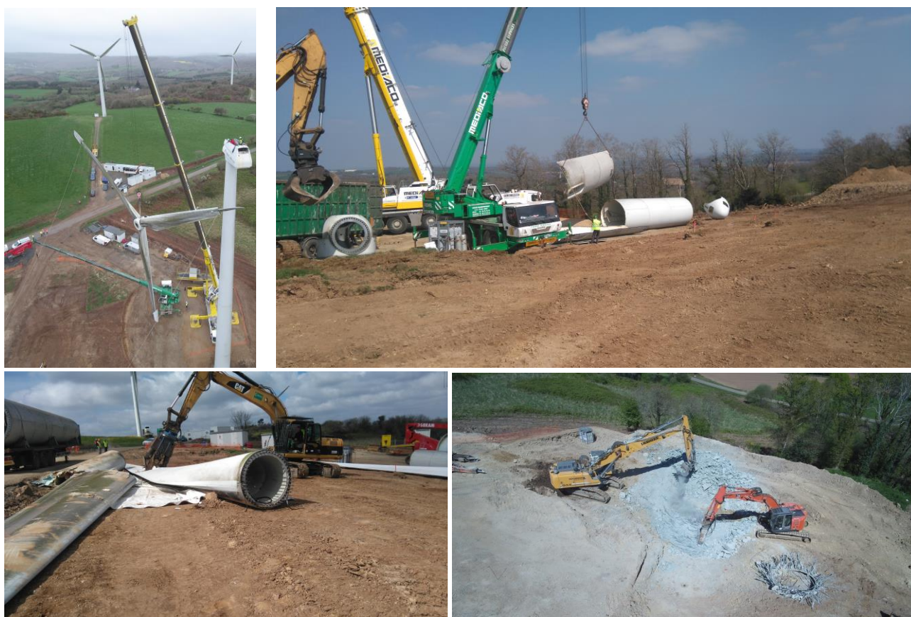
Figure 6: démantèlement du parc éolien de Plouyé (démontage de l'éolienne, cisailage de la pale, destruction de la fondation)
